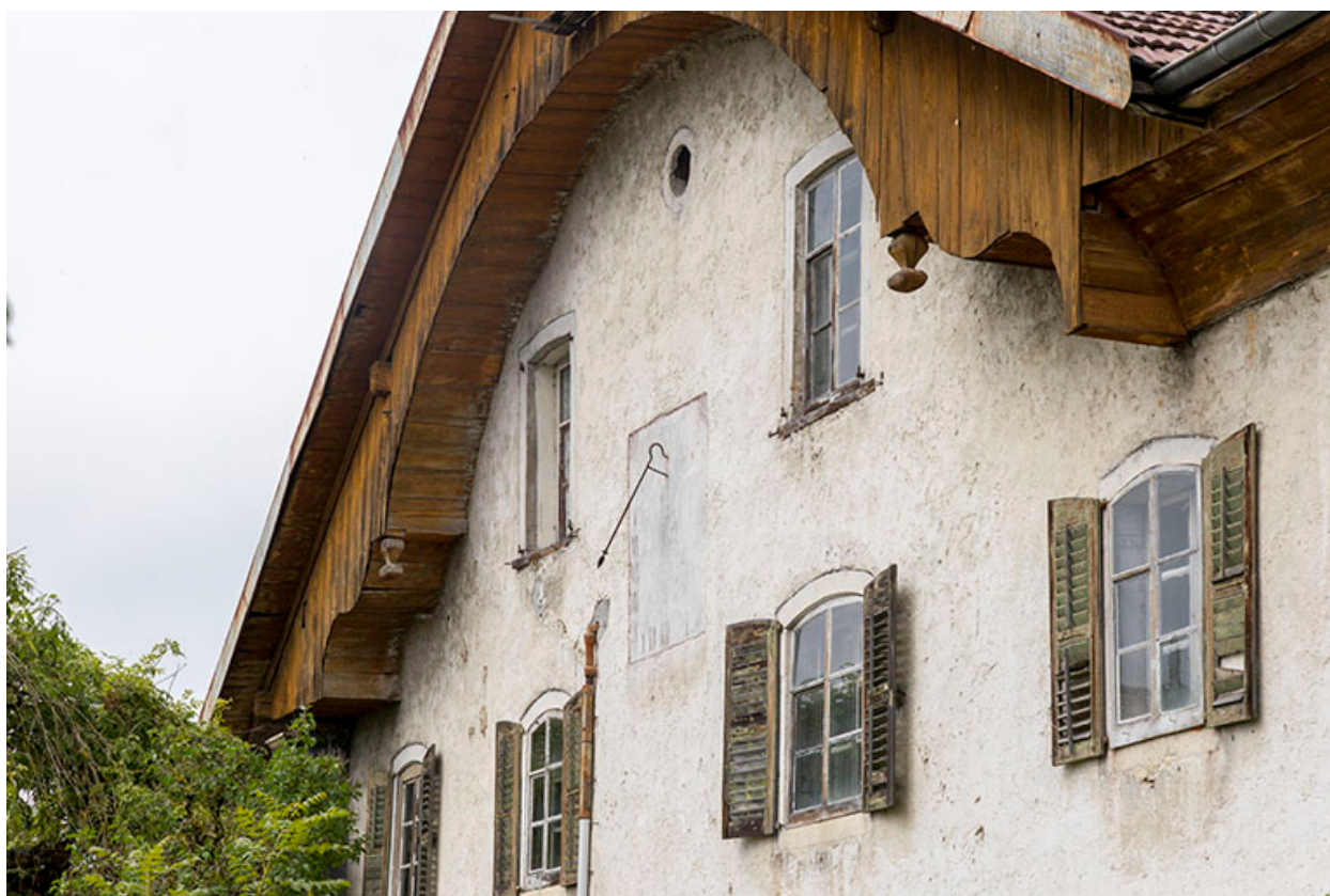
Façade antérieure : pignon et cadran solaire.
