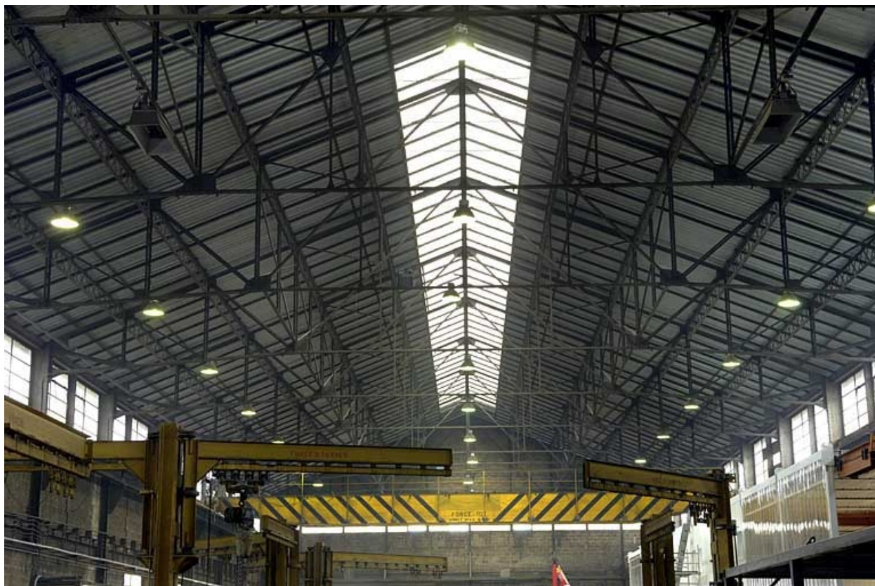
Atelier de fabrication. Charpente et couverture métallique.
