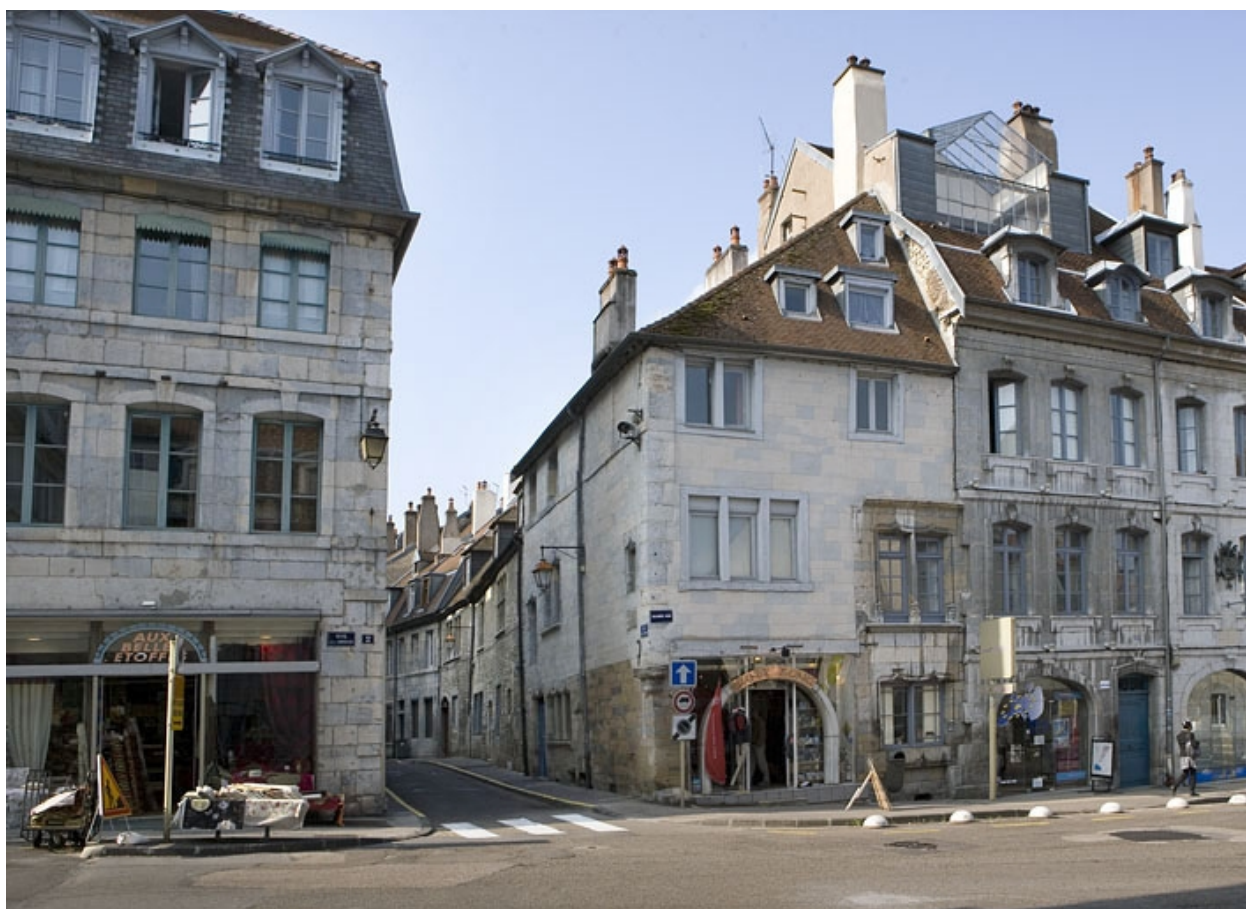
Vue d'ensemble éloignée.
