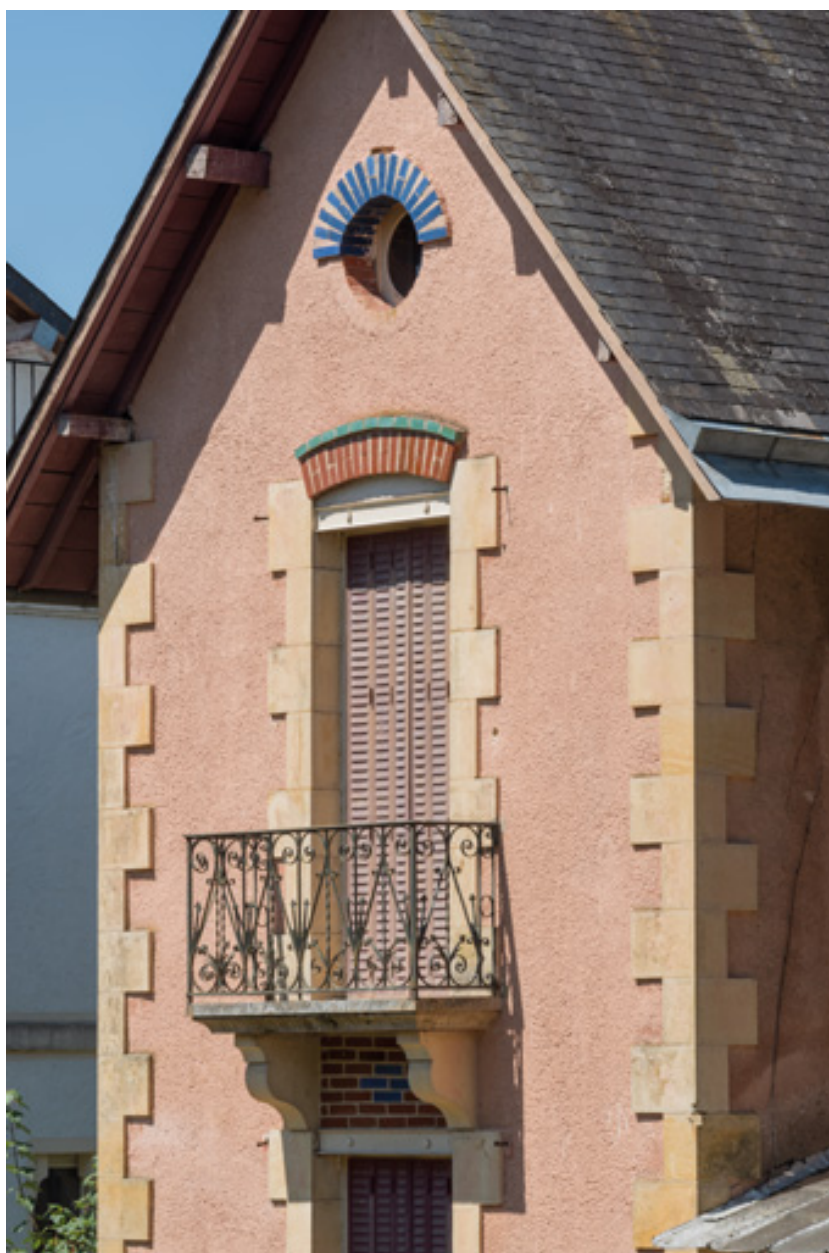
Mur-pignon, détail des ouvertures, vue de trois-quarts.
