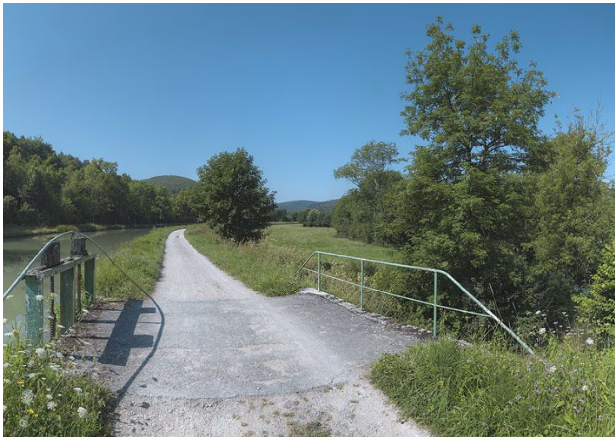
Vannes et garde corps du déversoir.
