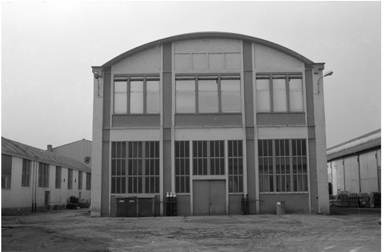
Atelier de réparation (5).
