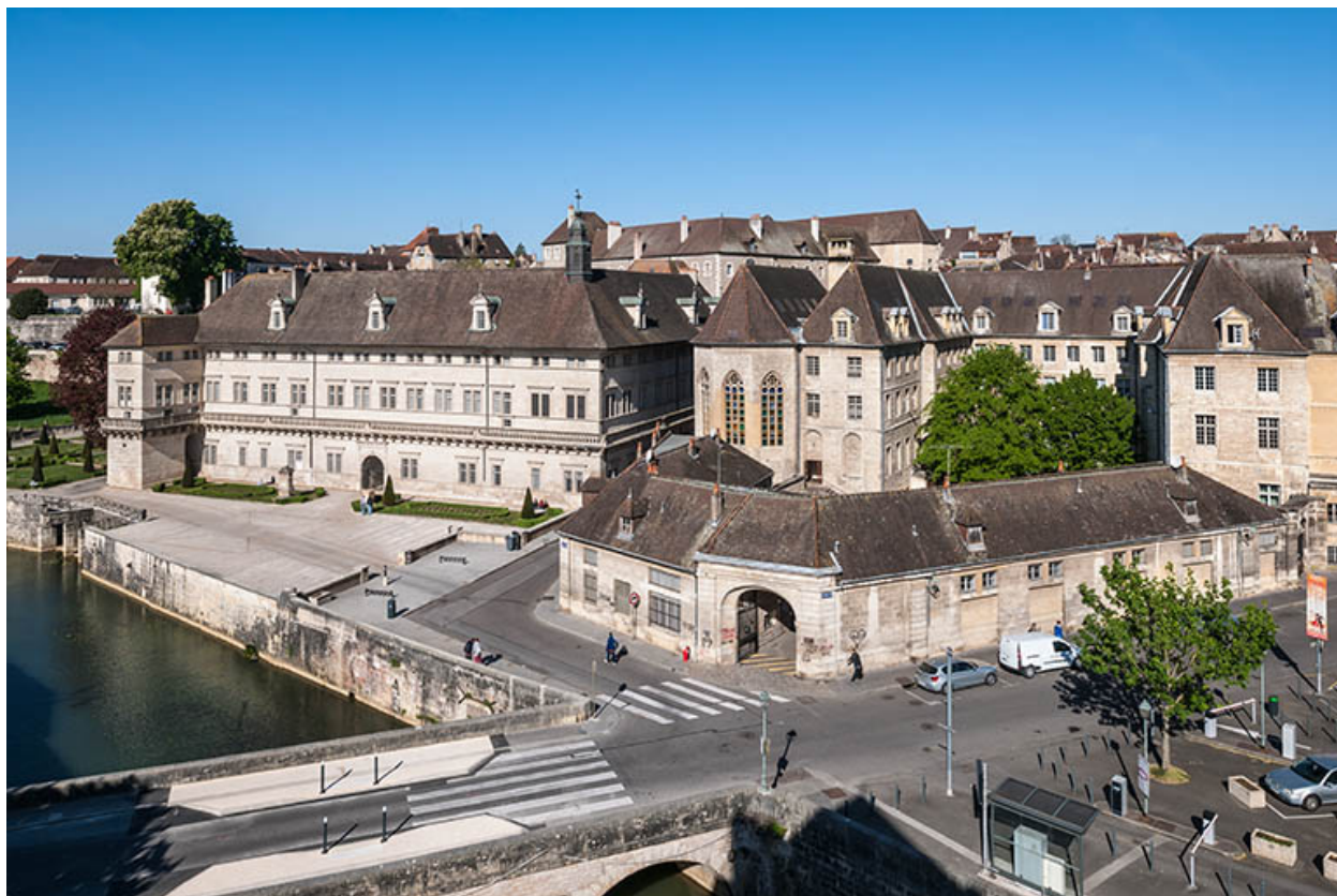
Vue générale depuis le sud.
