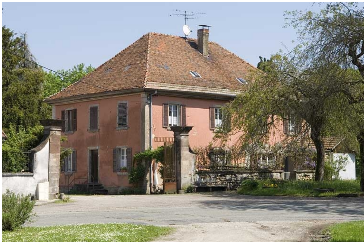
Saline de Gouhenans : bâtiment des bureaux.
