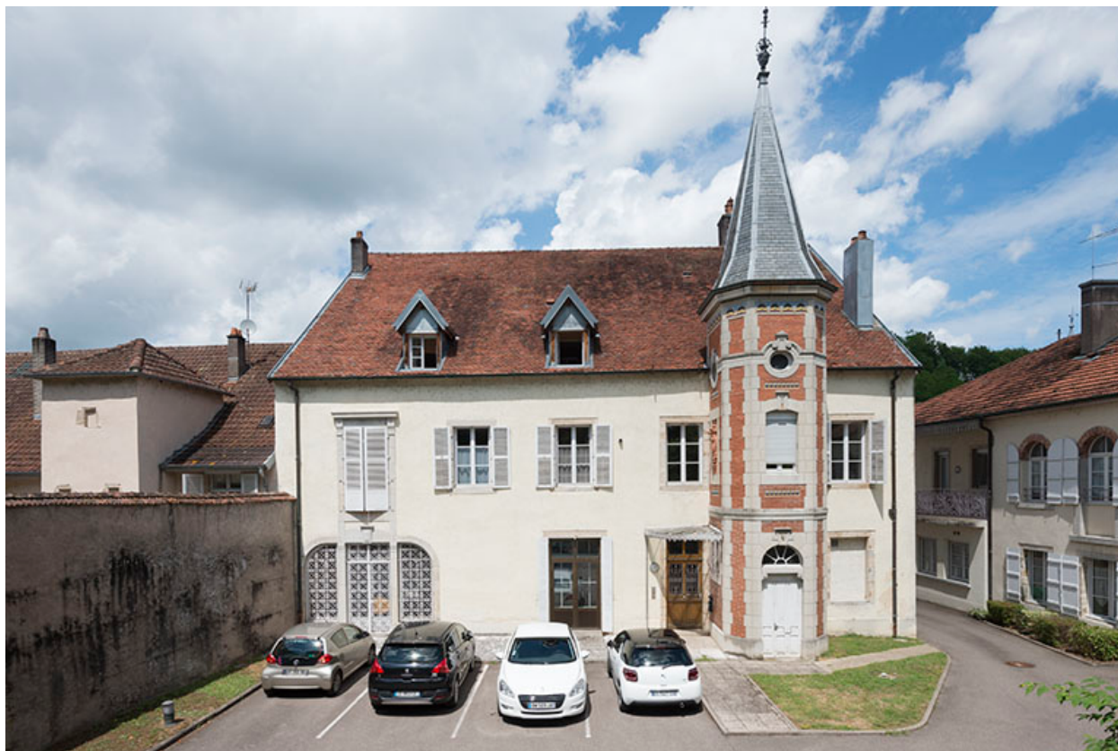
La façade postérieure.
