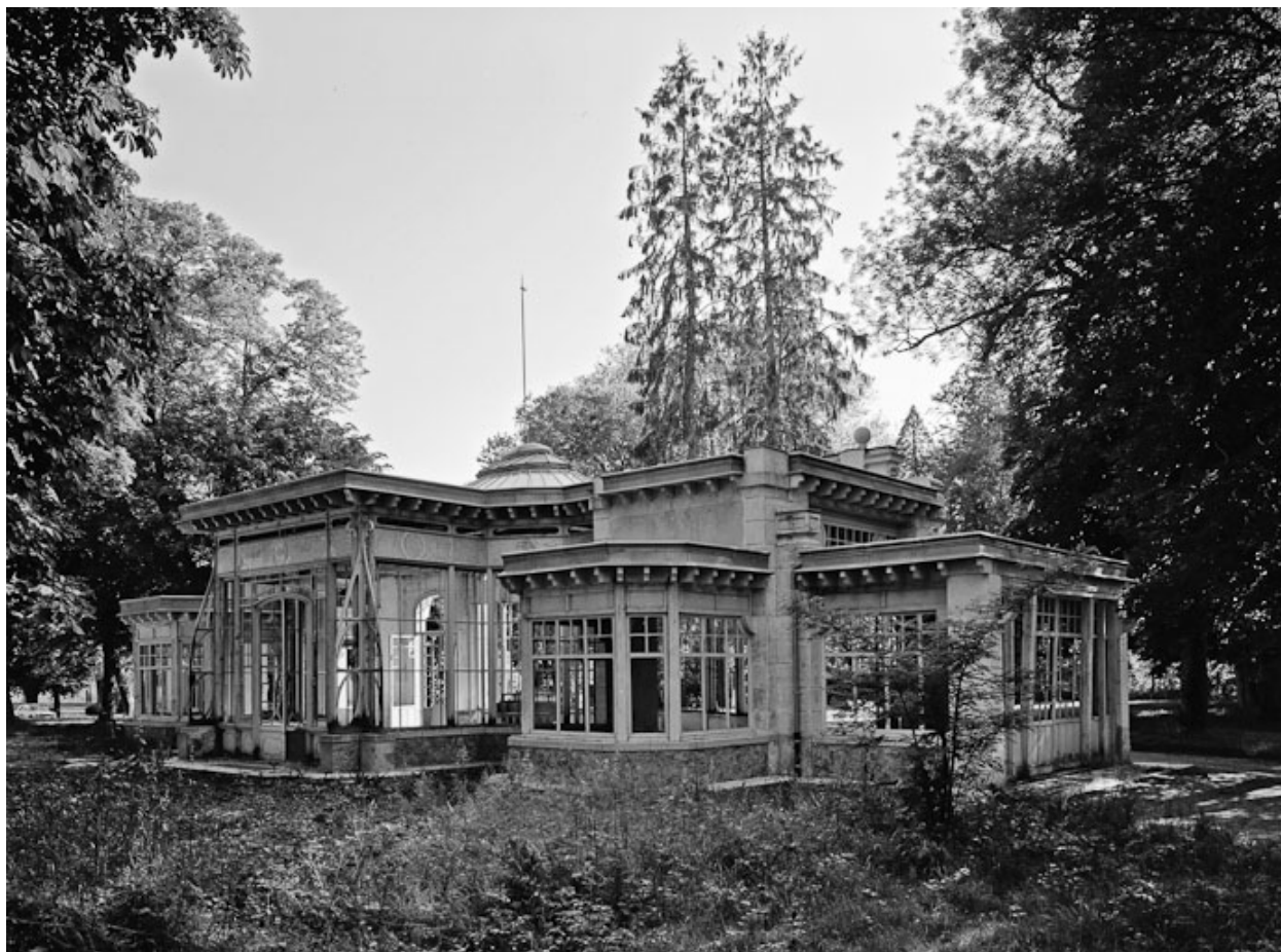
Façade est, vue en 1984.
