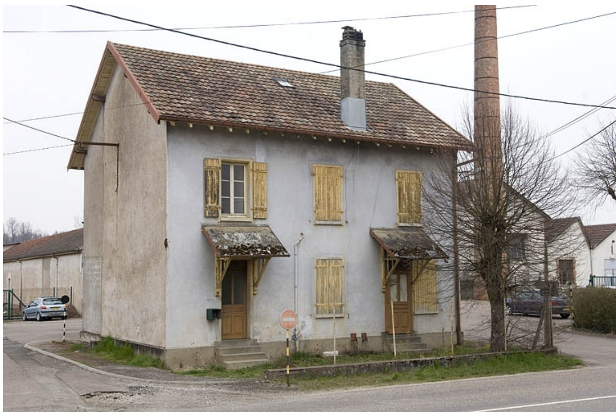
Logement à l'entrée de l'usine.
