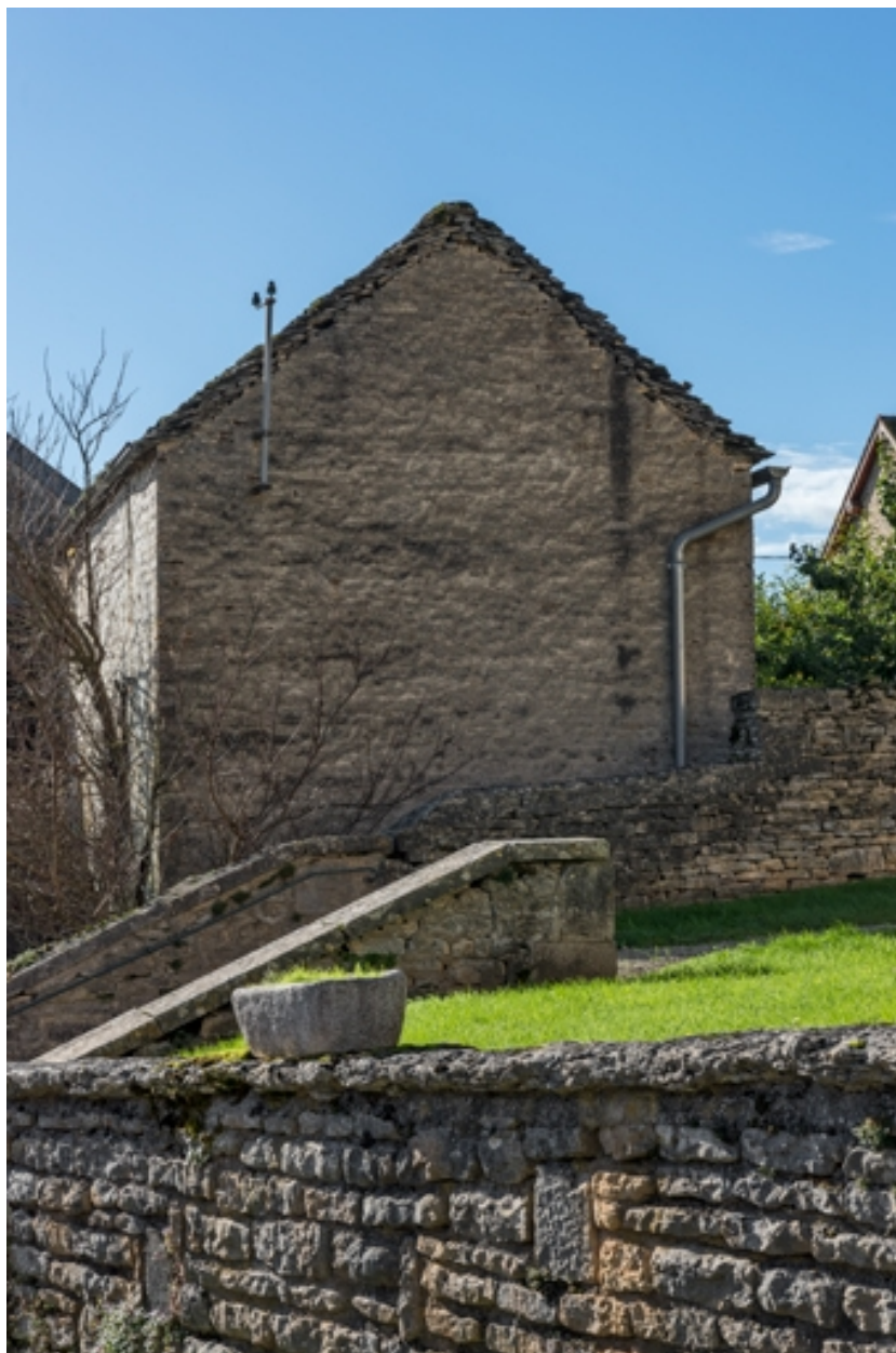
Vue du mur pignon nord.
