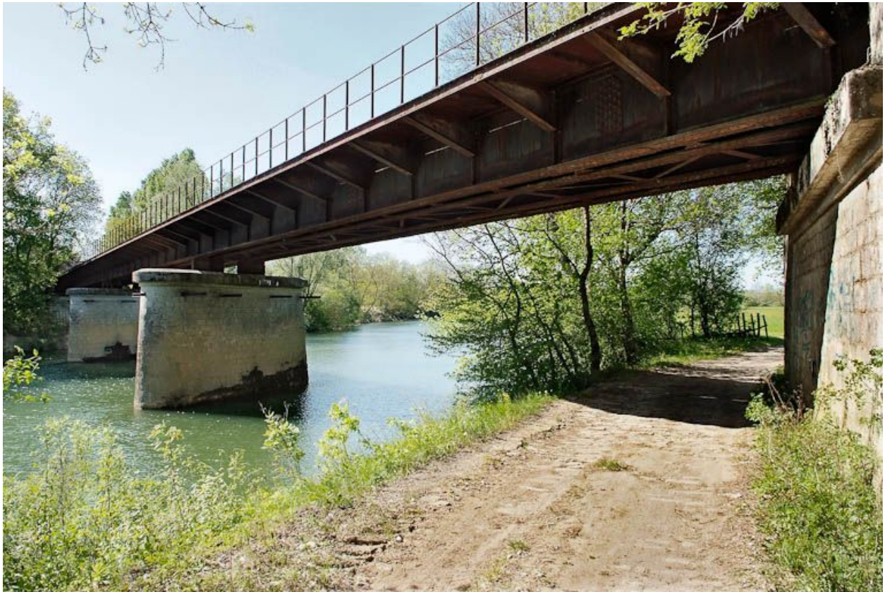
Pont de chemin de fer de Ratenelle, désaffecté, vu du dessous.
