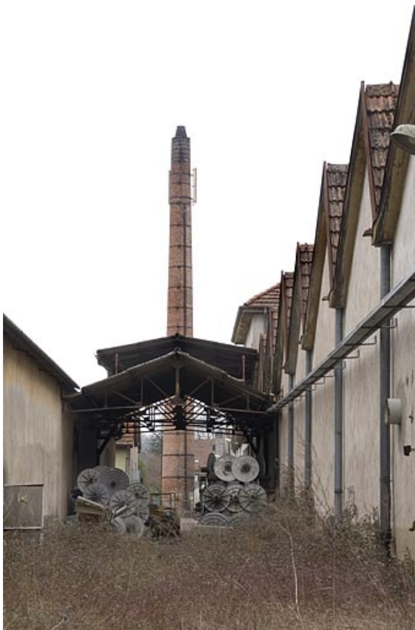
La cheminée vue depuis le nord.
