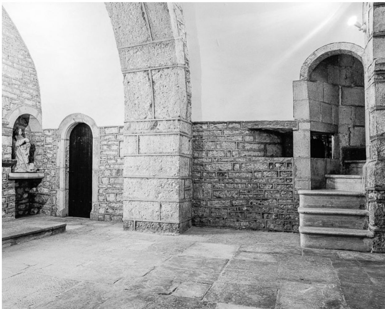
Bas côté droit, deuxième travée, mur ouest.
