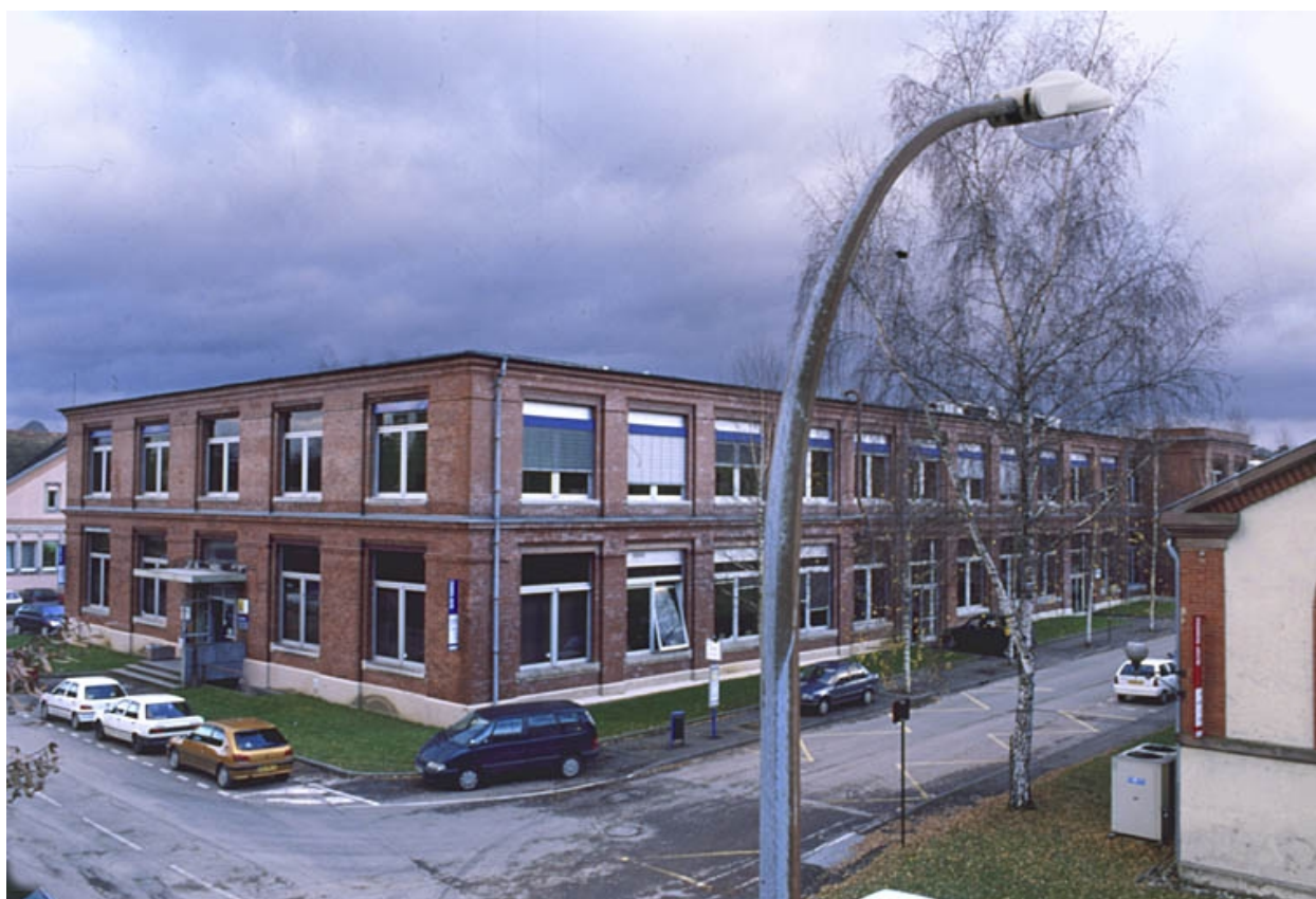
Atelier de finissage : extrémité nord vue de trois quarts.
