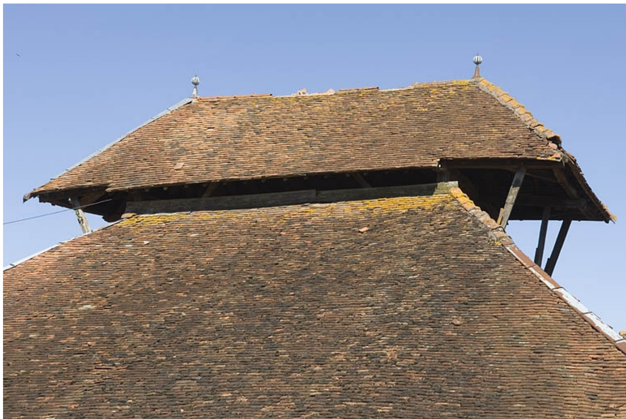
Lanternon du bâtiment du four.
