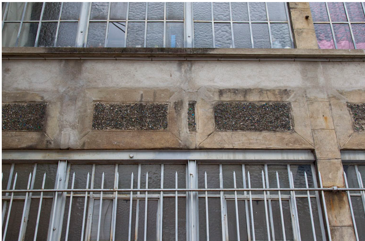
Atelier de fabrication. Détail des allèges la façade.
