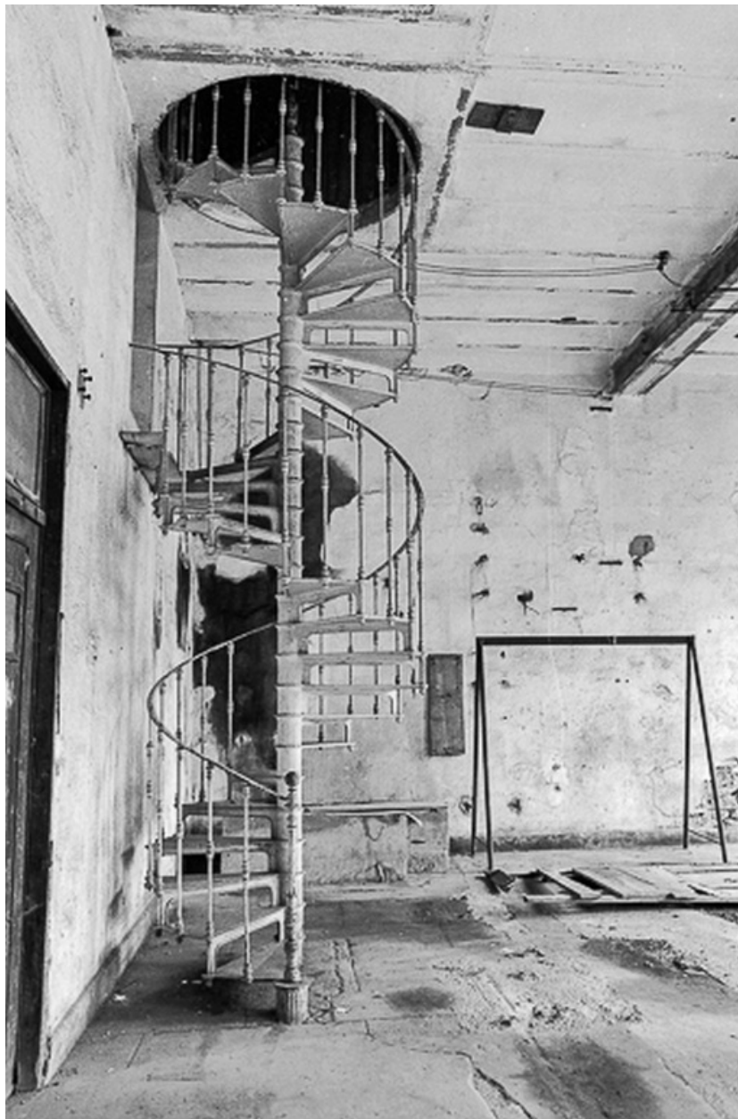
Vue intérieure en 1979. Escalier métallique.
