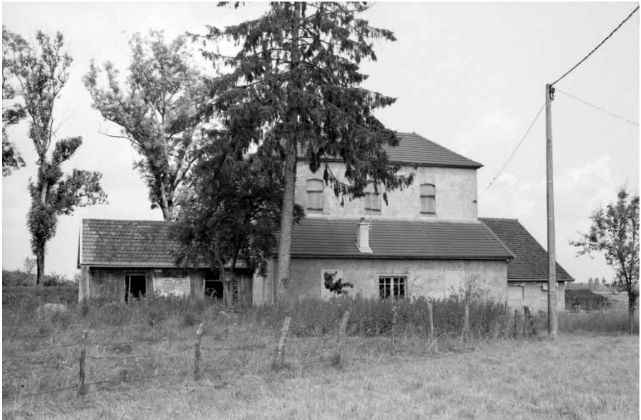
Atelier de fabrication (A).
