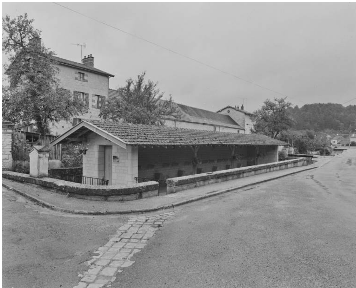
Vue d'ensemble coté source
