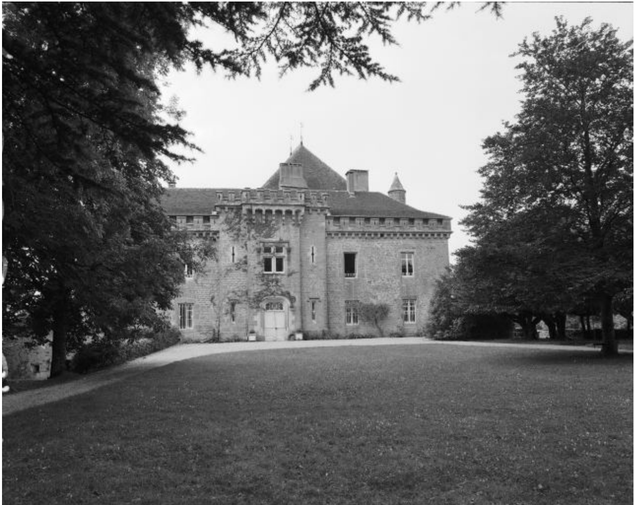
Le corps de bâtiment de façade.
