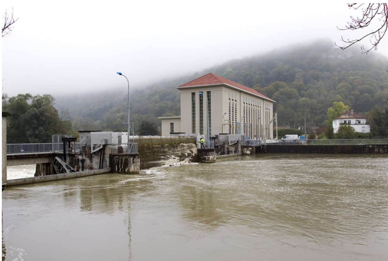
Le barrage et la centrale depuis l'ouest.
