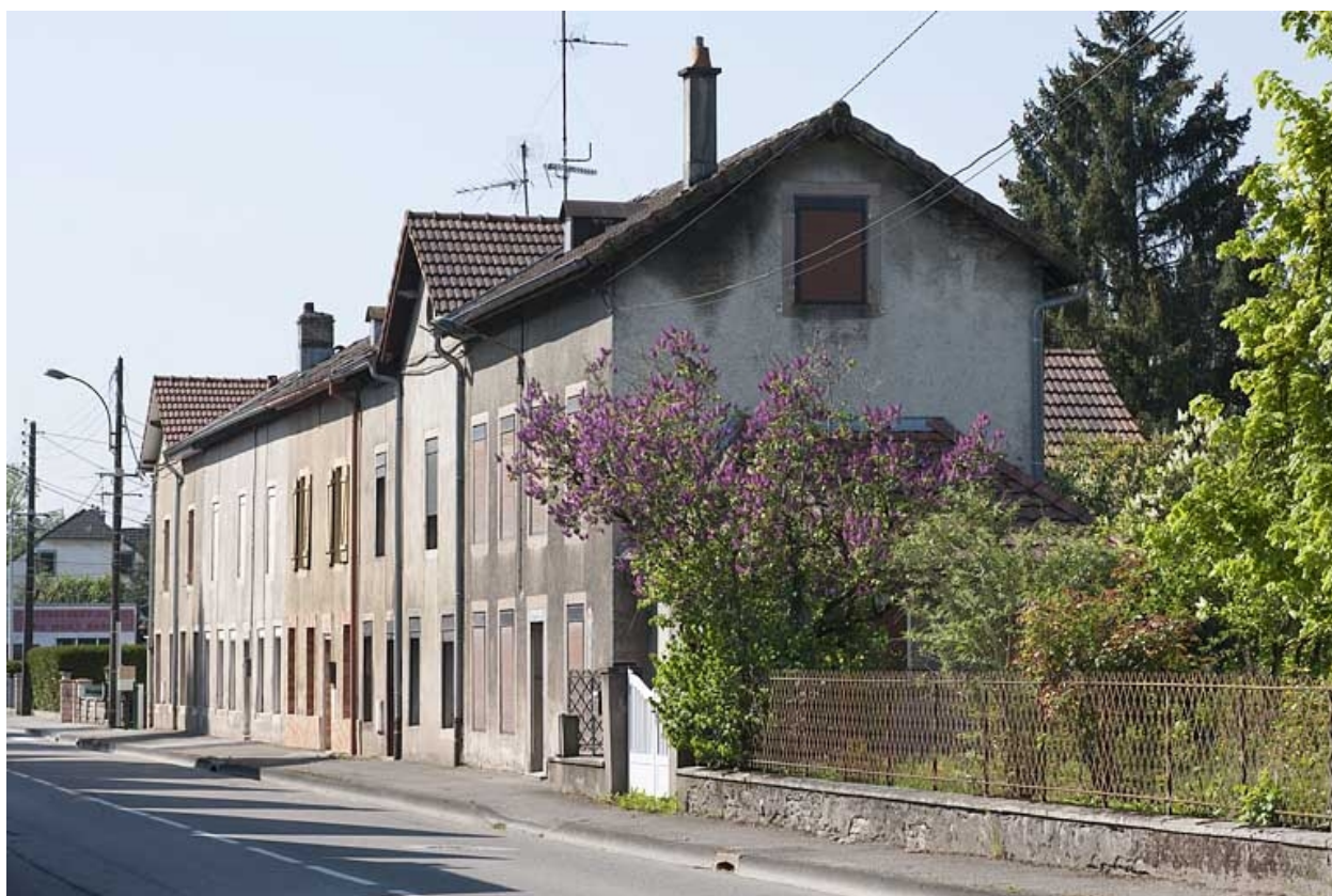
Logements ouvriers. Vue de trois quarts droite.
