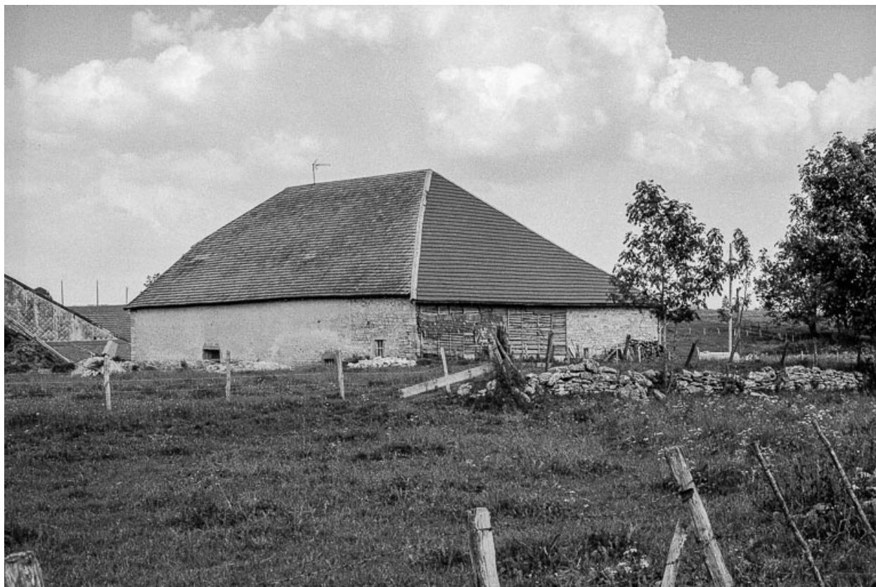
Ferme, cadastrée 1938 F 62 : façade postérieure.
