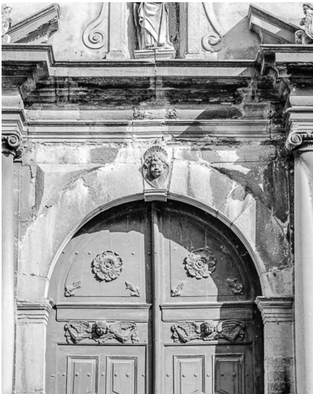
Portail de la façade antérieure : : partie supérieure.
