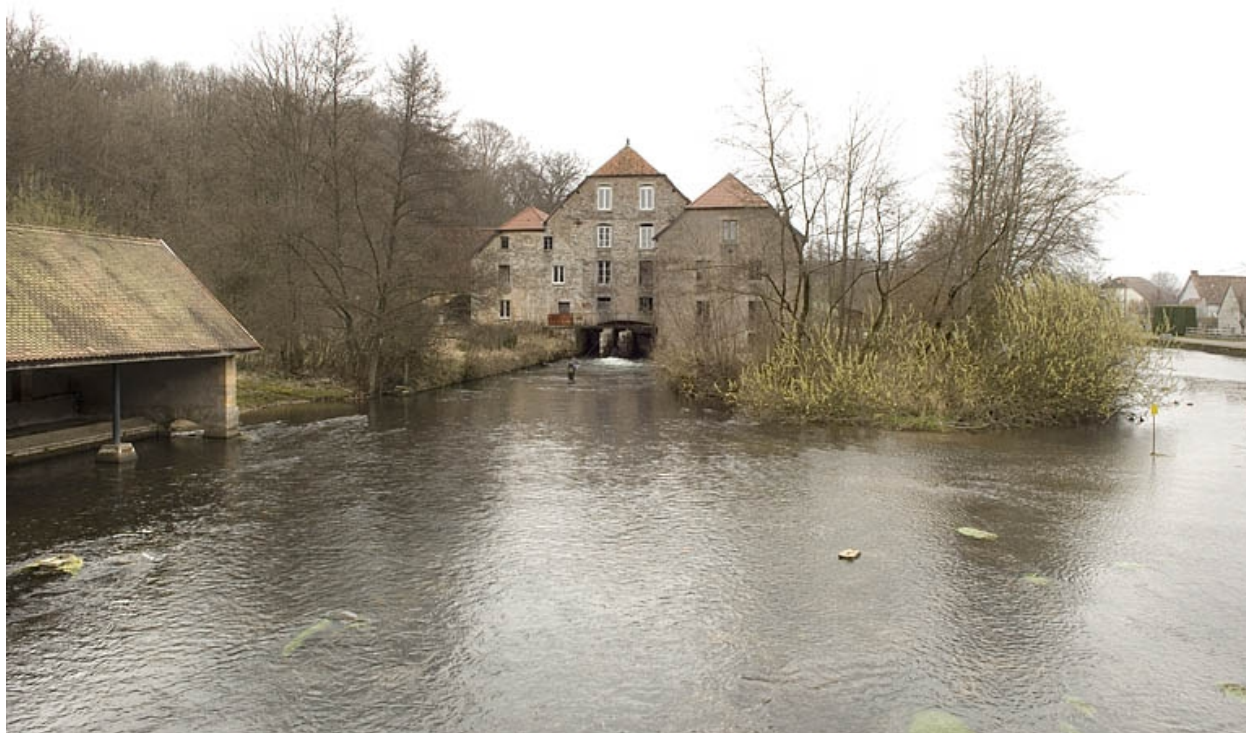
Vue d'ensemble depuis le pont.
