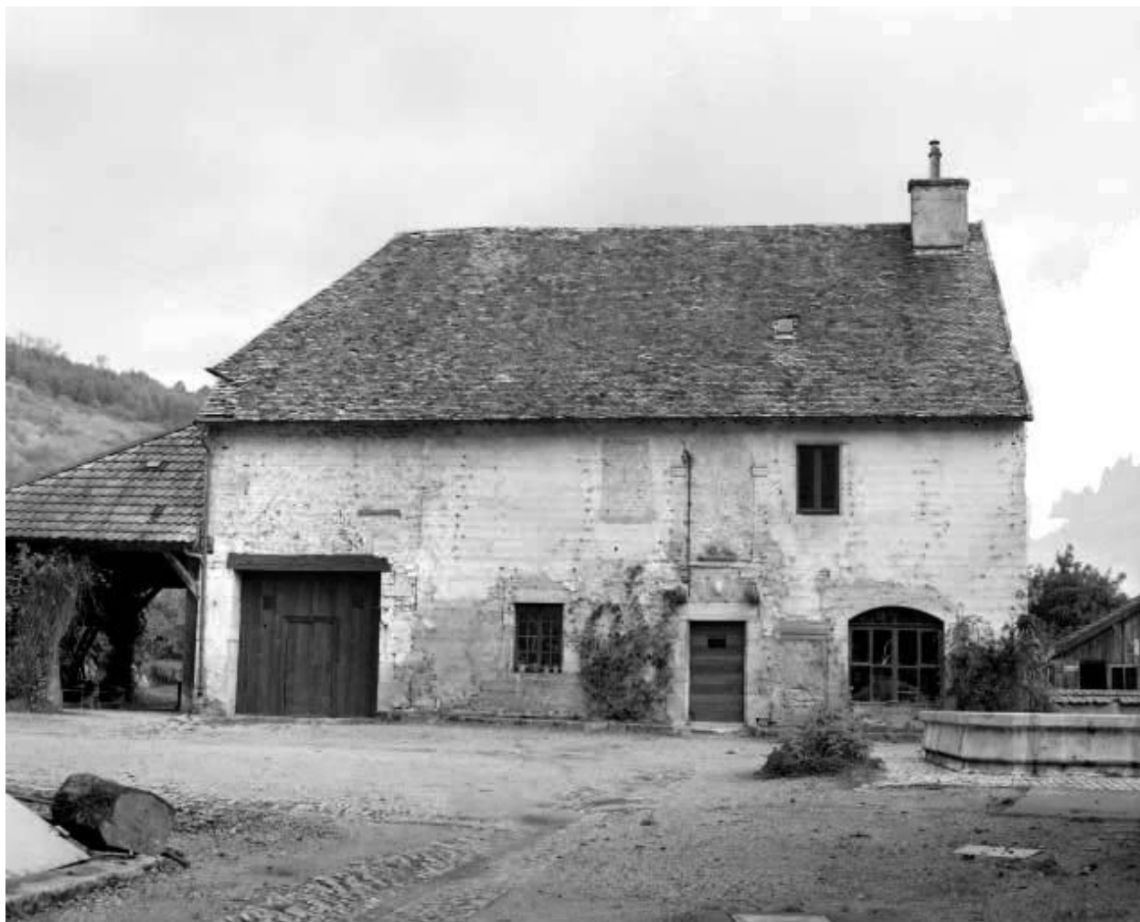
Façade antérieure de l'ancienne hôtellerie.
