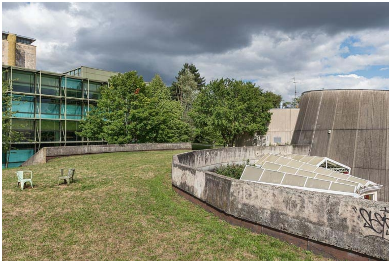
Aile semi-circulaire : toiture végétalisée.
