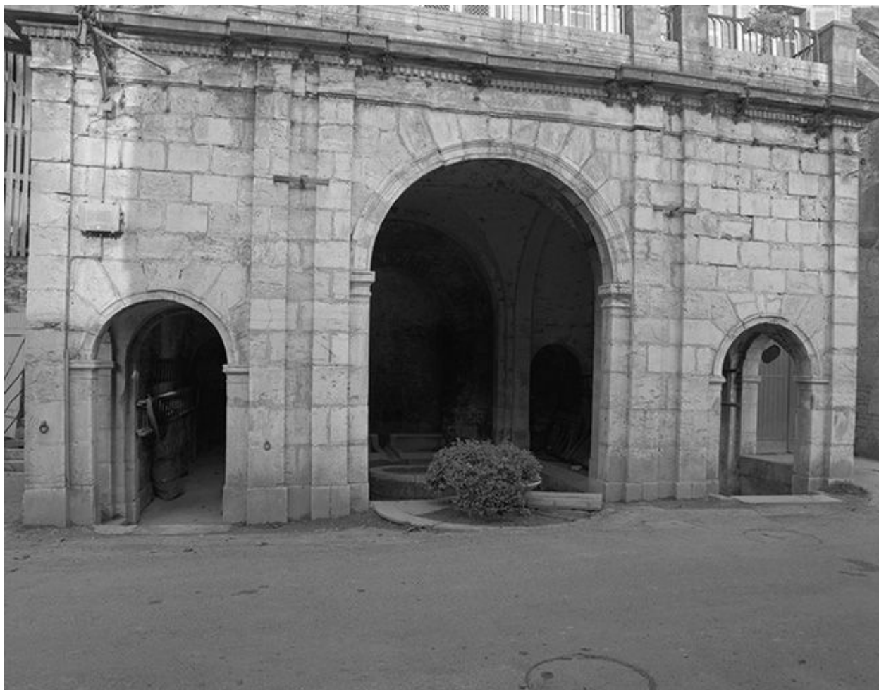
Façade antérieure : détail du rez-de-chaussée.
