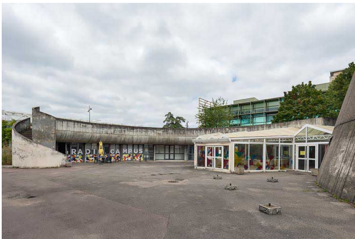
Façade sur cour.
