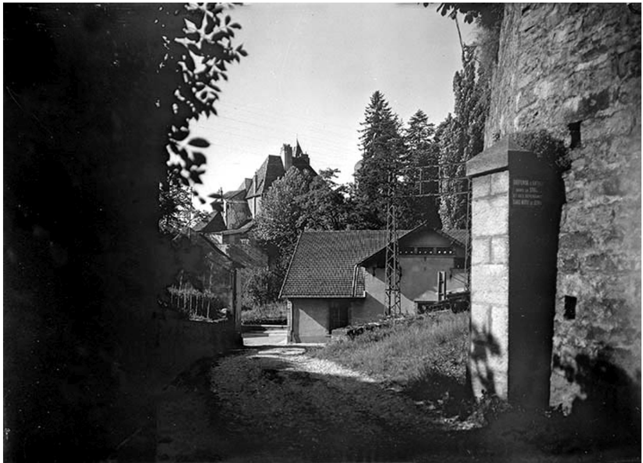
La centrale hydroélectrique depuis l'entrée.
