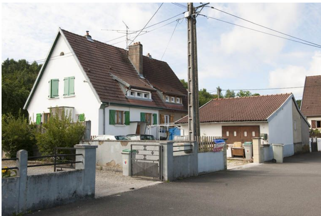
Maison et garage vus de trois quarts.
