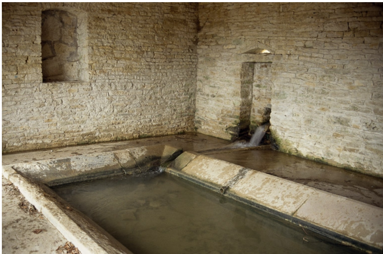
Vue générale intérieure.
