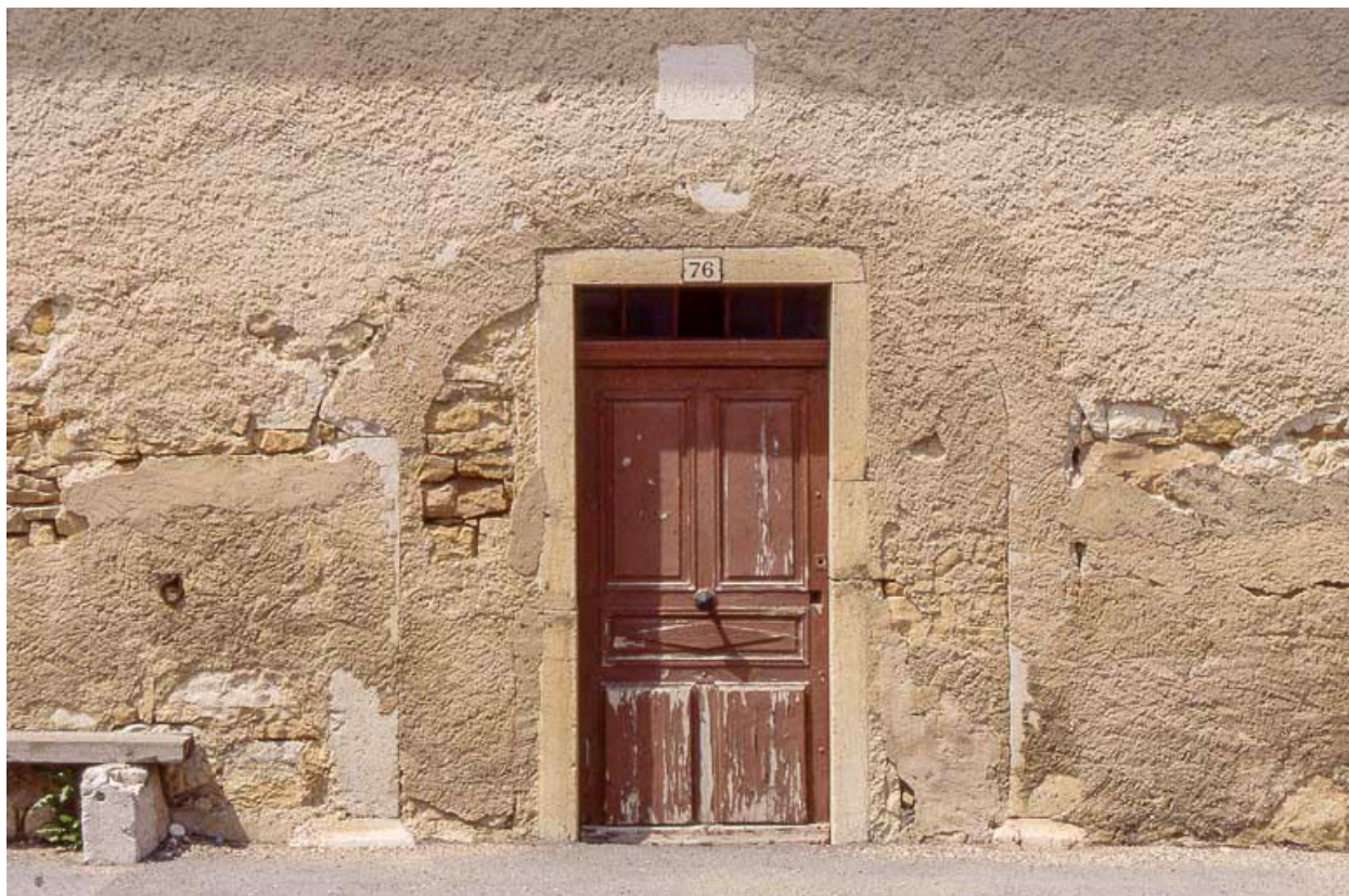
Porte sur la façade antérieure.
