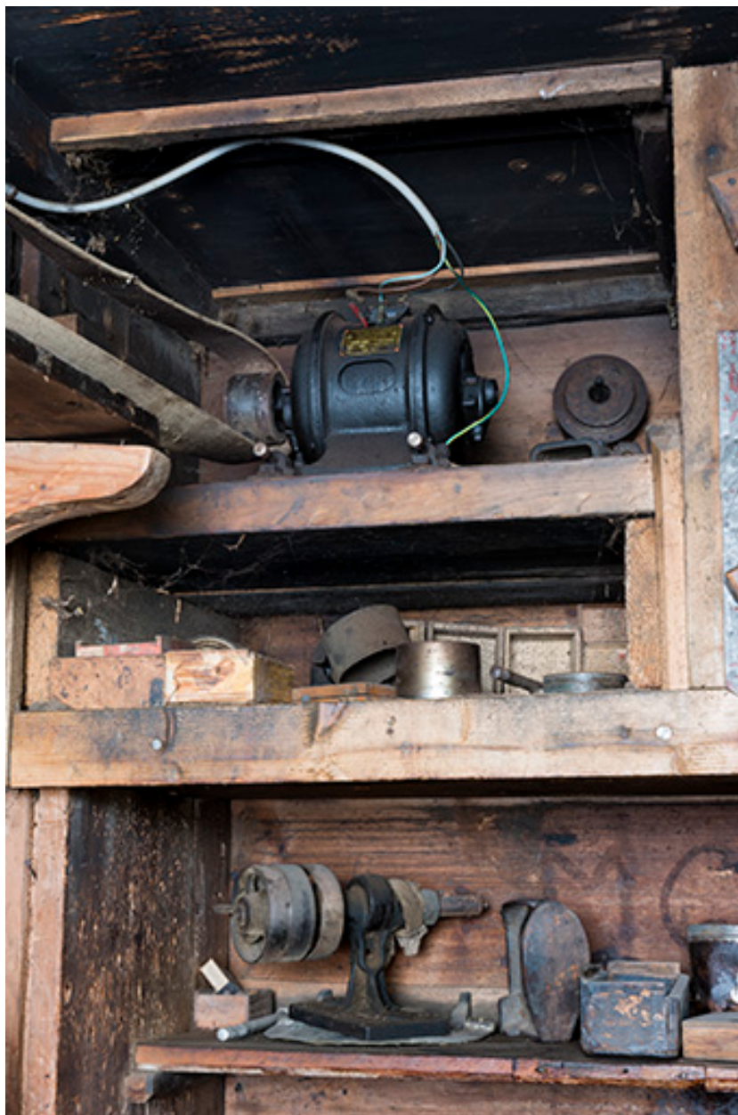
Atelier : moteur électrique et étagères.
