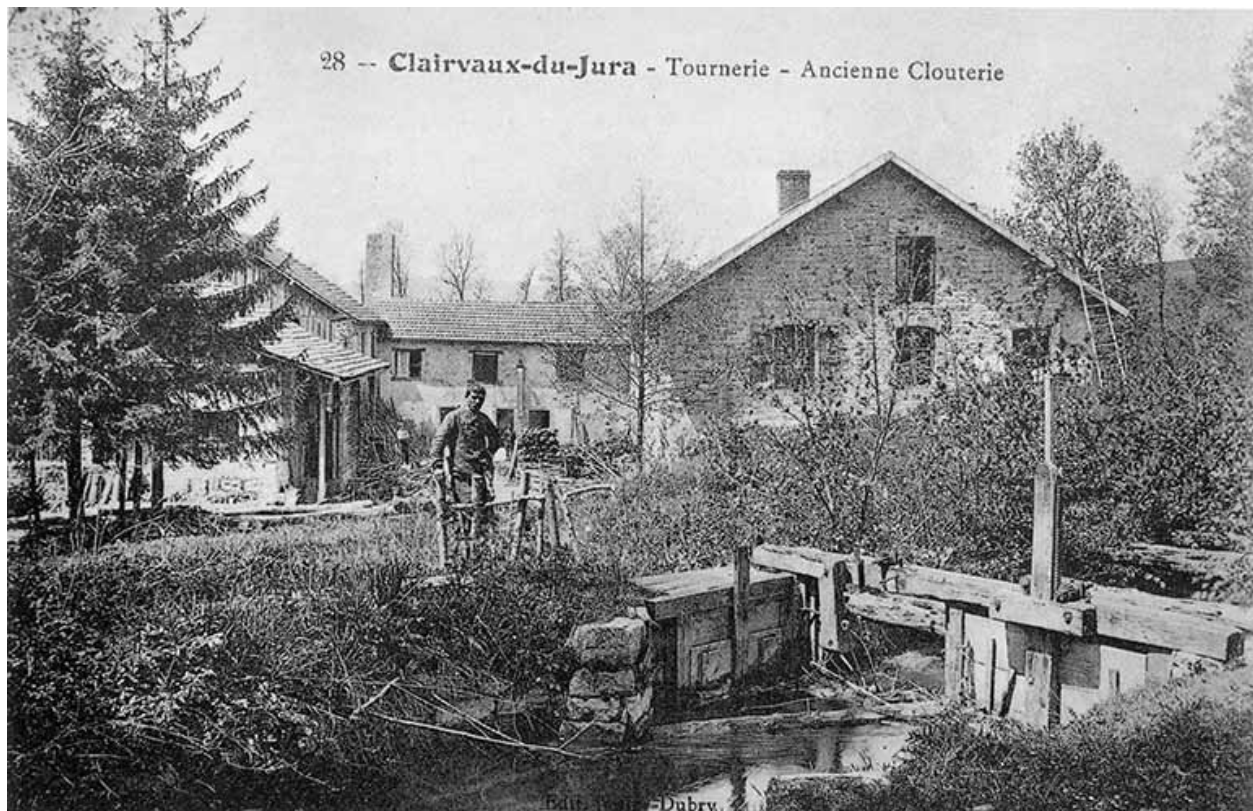
Clairvaux du Jura - Tournerie - Ancienne clouterie.
