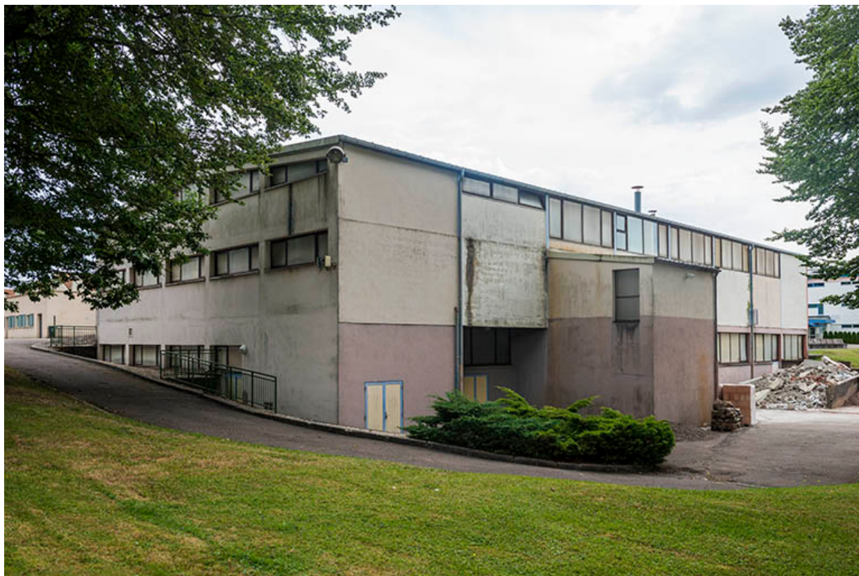
Atelier de gros-oeuvre : façade postérieure.
