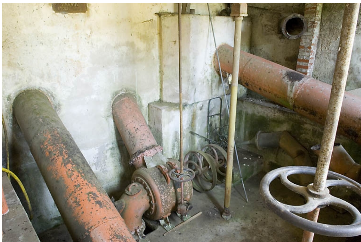
Intérieur du bâtiment d'eau.
