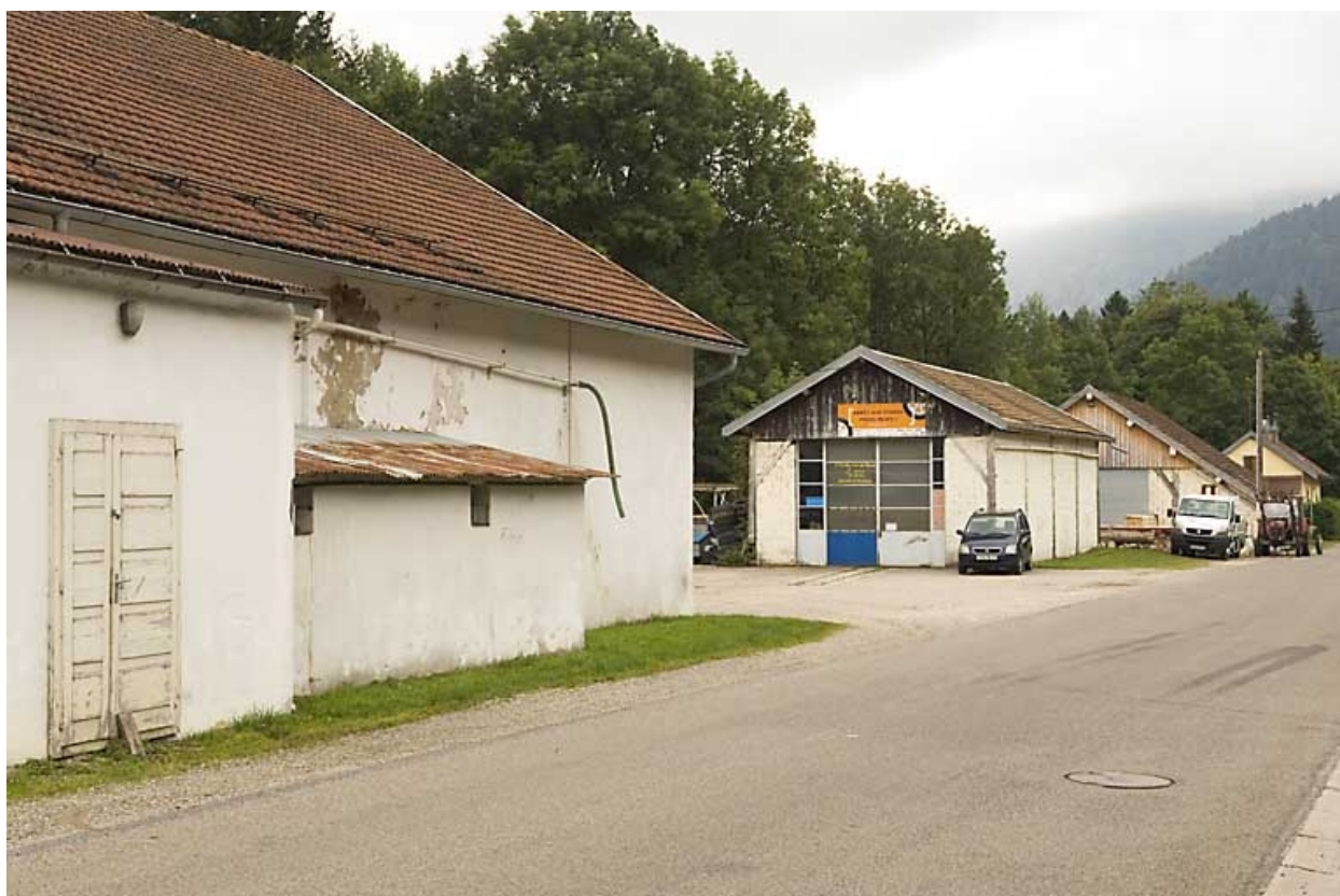
Partie sud du site : vue générale.
