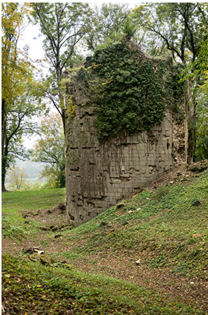
La tour ouest : vue rapprochée du sud.
