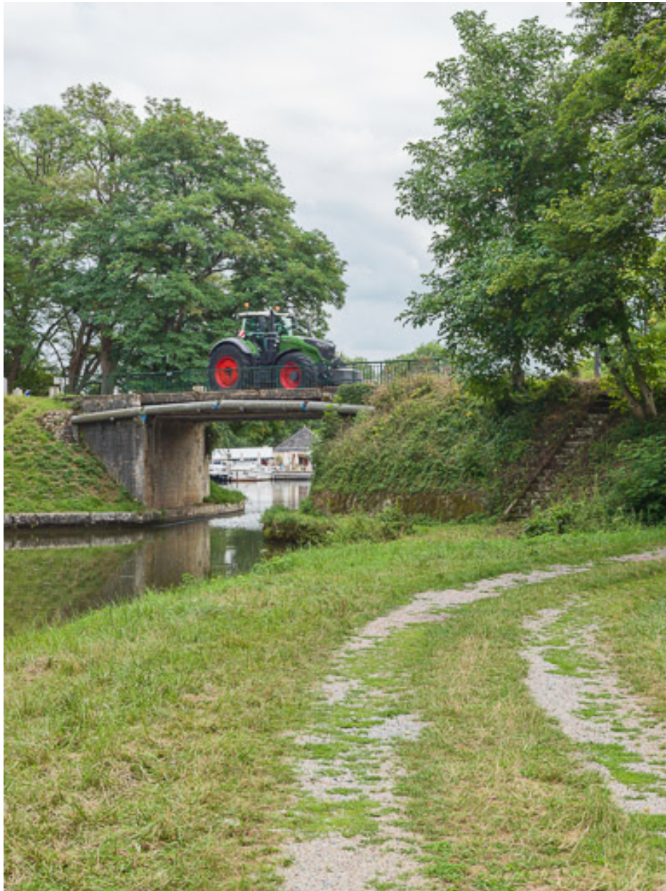
Vue d'ensemble du pont.
