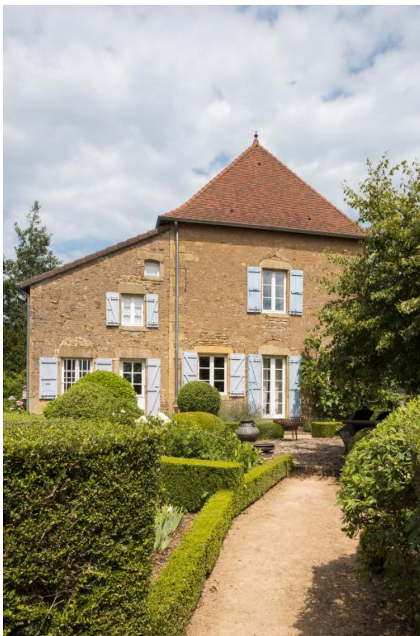
Façade latérale ouest de la maison
