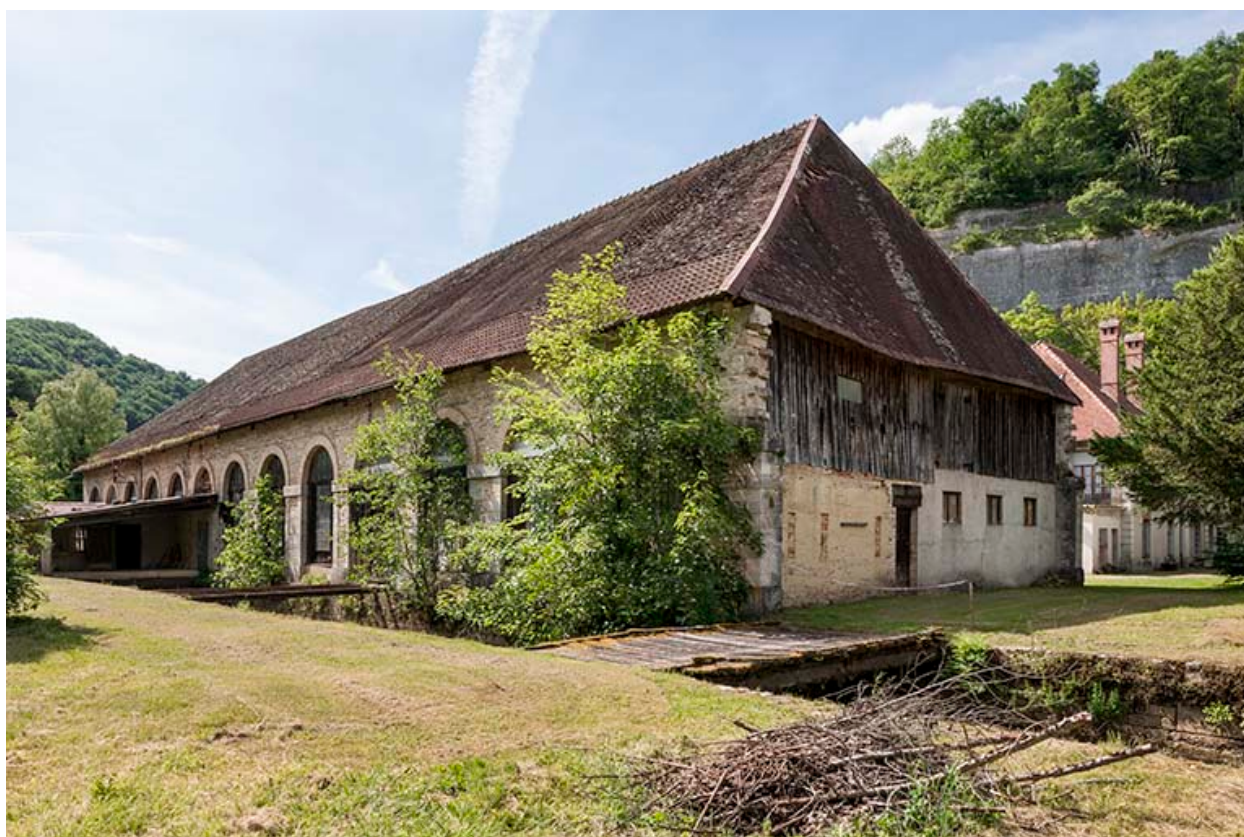
Atelier de fabrication depuis le sud-est.
