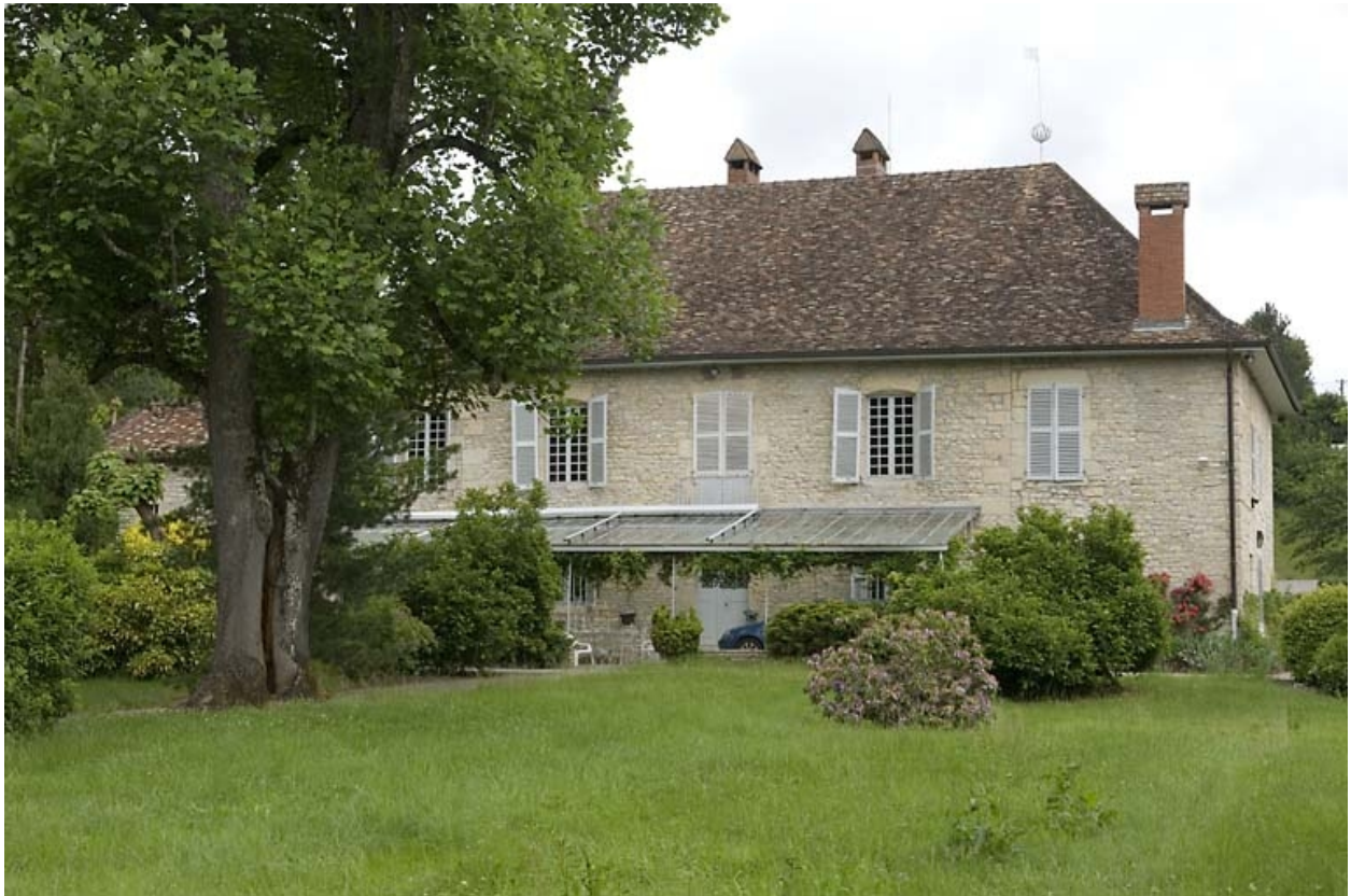
Façade antérieure du logement patronal.
