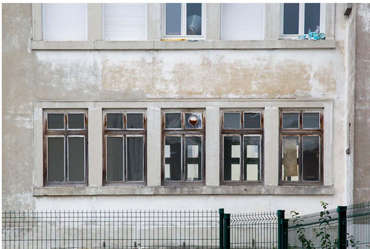
Façade postérieure : fenêtres multiples.
