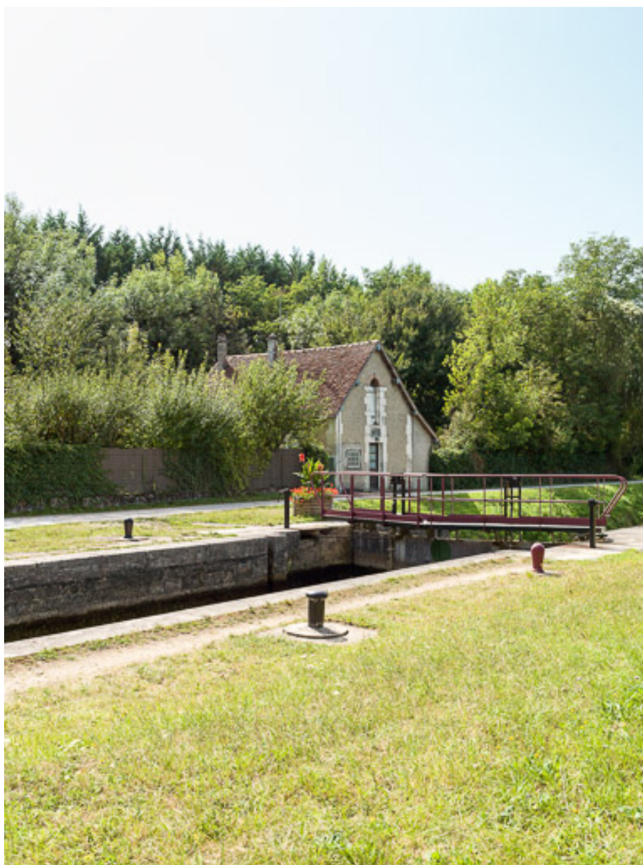
Vue du site d'écluse.
