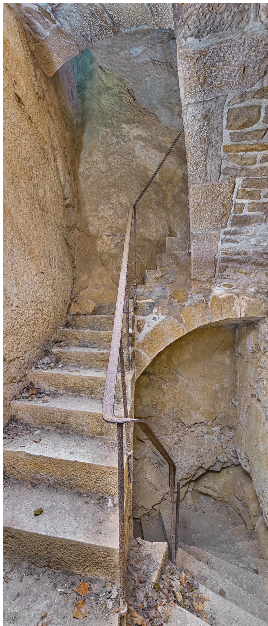
Escalier desservant les étages inférieurs.
