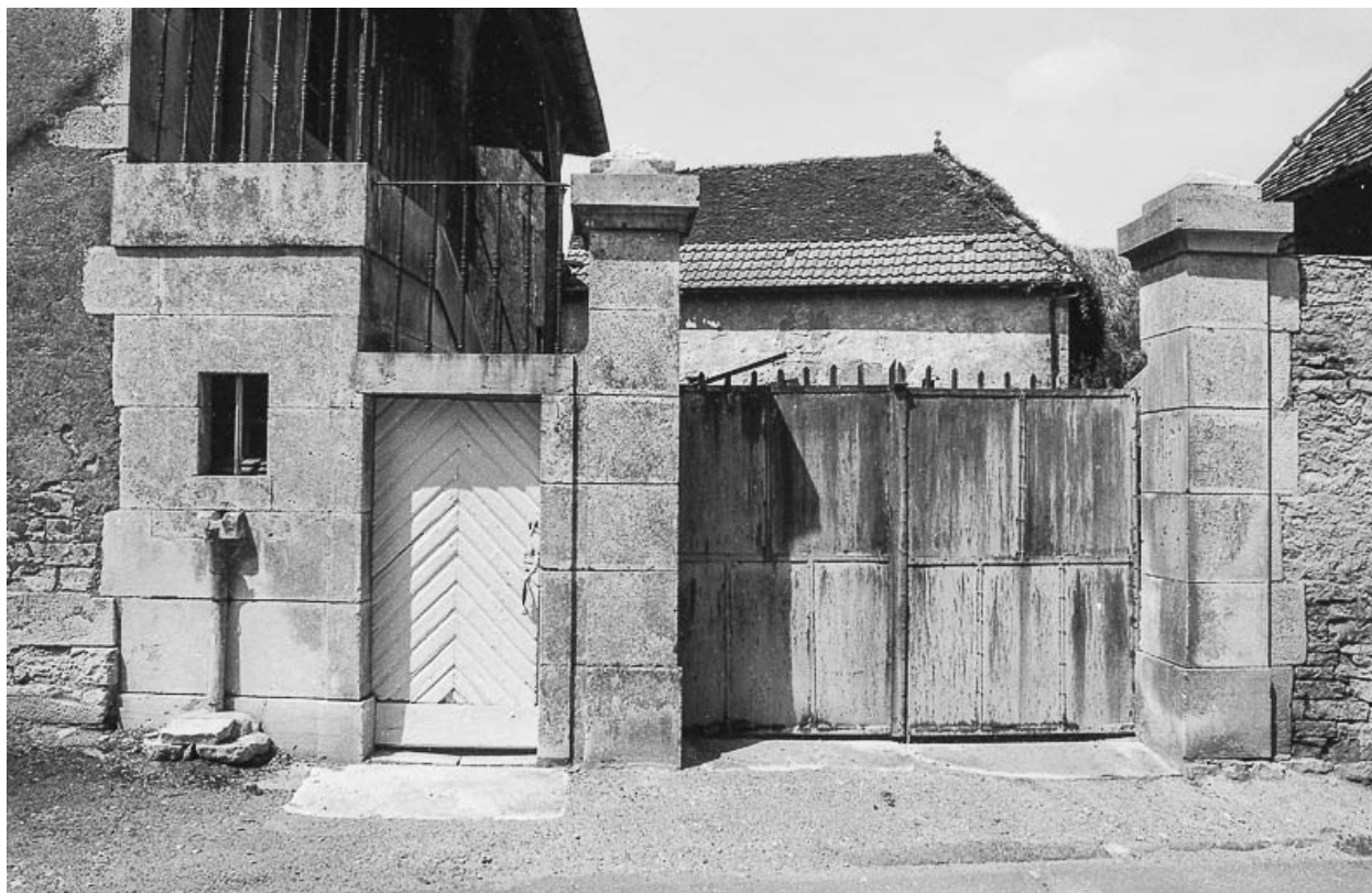
Vue rapprochée du portail d'entrée.
