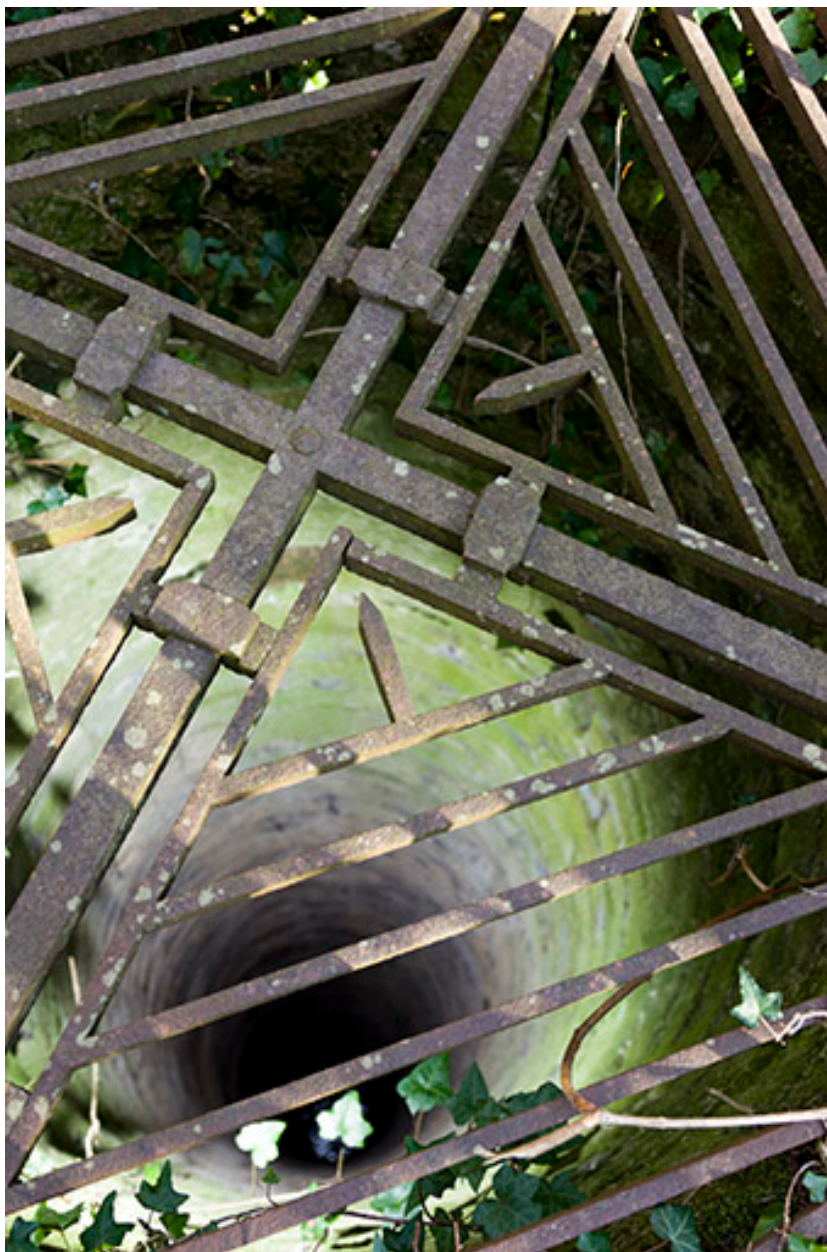
Vue du puits depuis l'orifice.
